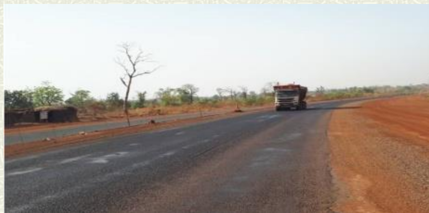
Bitumage ou arrosage des pistes de chantier
